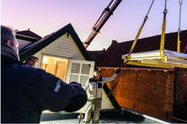
In der Nähe der Dachöffnung platzieren. Hebegeräte unterhalb der Palette anbringen.
