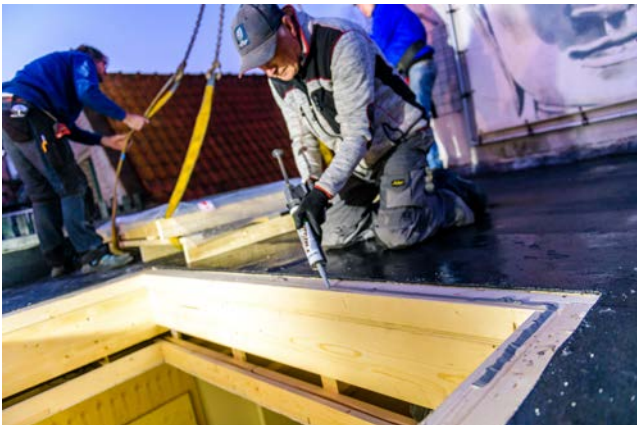
Dichtungsmasse auf den Randbalken auftragen.
