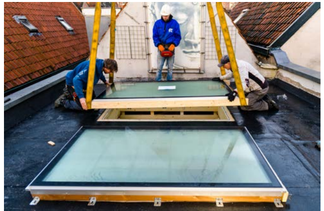
Anbringung von Oberlicht auf den Randbalken.
