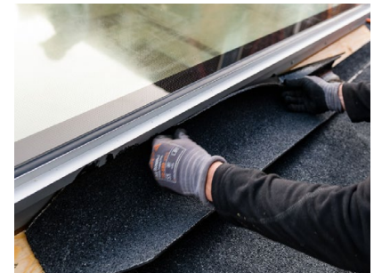
Anbringung der Dachabdeckung.
