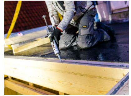
Dichtungsmasse auf den Randbalken auftragen.
