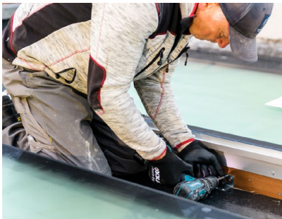
Befestigung des Oberlichts an der Dachkonstruktion.
